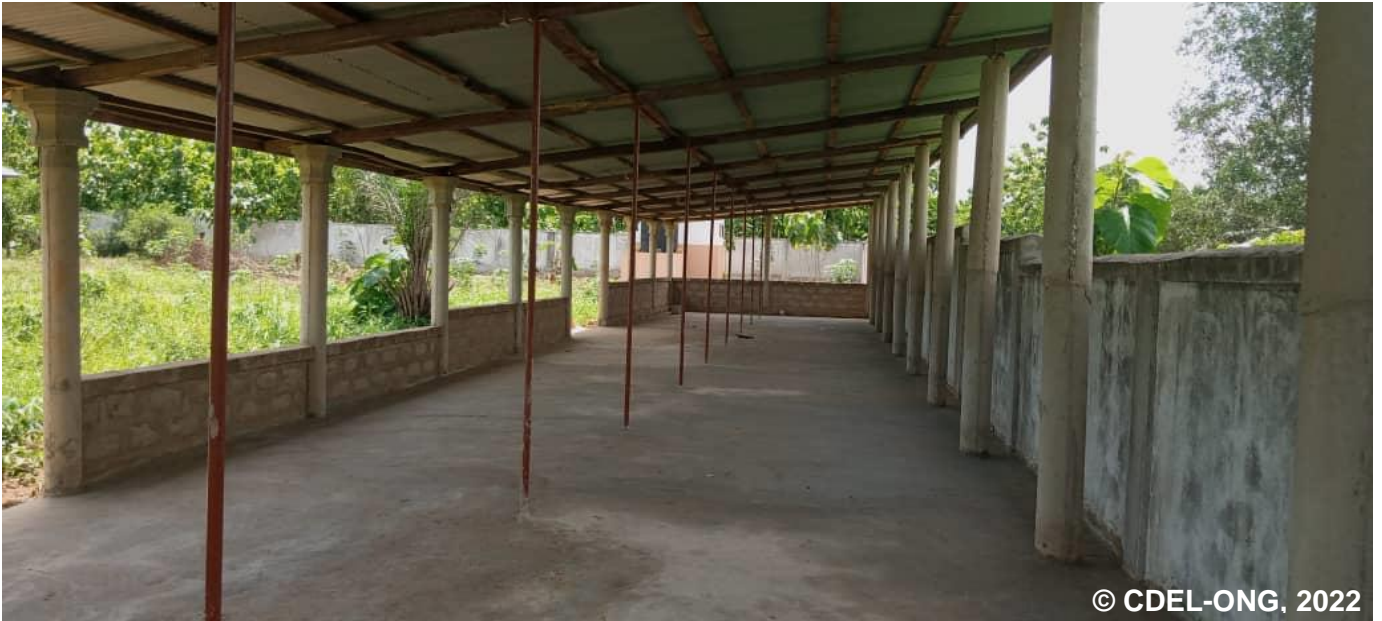
Photo 3 : Vue de l'intérieur du hangar à fin Avril 2022
